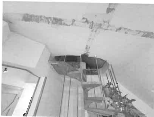
Tervezett részleges bontással érintett 4. emelet feletti földém
